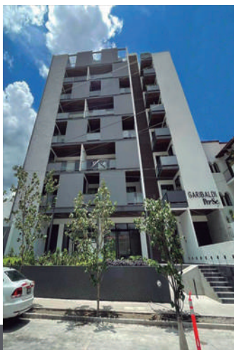
Garibaldi 32 departamentos 6 oficinas
